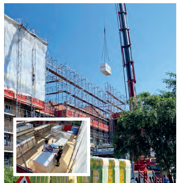
Materialer kan løftes ind på ladetårnene - og derefter flyttes med Conhoist
